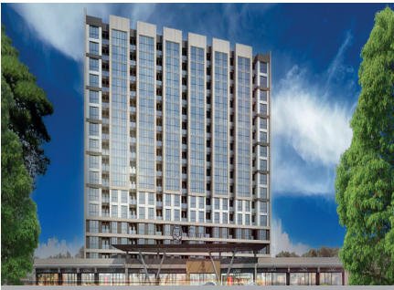
Ak Yapı Mavera Residence
